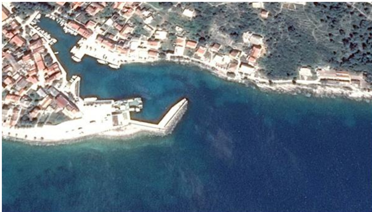
Slika 3.1.-1.: Postojeći trajektni pristan
